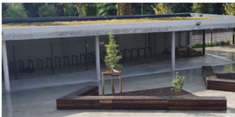
Local vélo ajouré sous un auvent qui permet également d'être abrité, école A la croisée des chemins, Bruxelles © Ville de Paris
