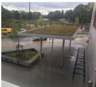
Auvent végétalisé, école A la croisée des chemins, Bruxelles © Ville de Paris
