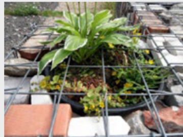
Gabion rempli de matériaux divers
