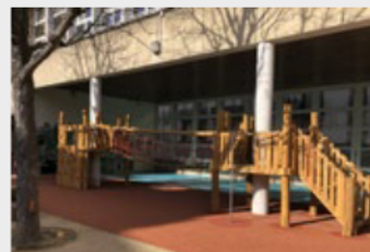
Plateformes autour des poteaux du préau, école Neuve-Saint-Pierre, Paris © CAUE de Paris
