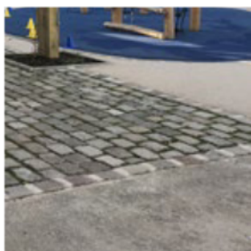
Limite entre pavés enherbés et béton drainant avec une bordure de pavés joints
