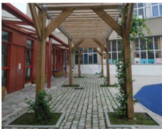
Pergola en bois avec ancrage au sol dans des fosses de pleine terre, cour Oasis de l'École Emile Levassor. © CAUE de Paris
