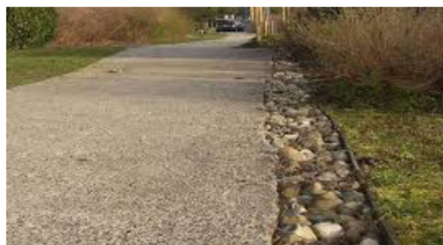
Tranchée drainante © Grand Lyon
