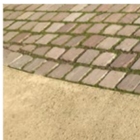
Limite entre pavés enherbés et béton drainant avec une lisse métallique
